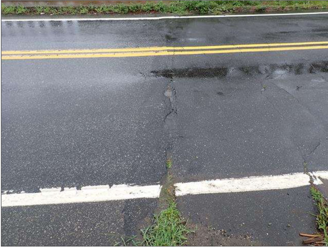
end bent 2 asphalt
