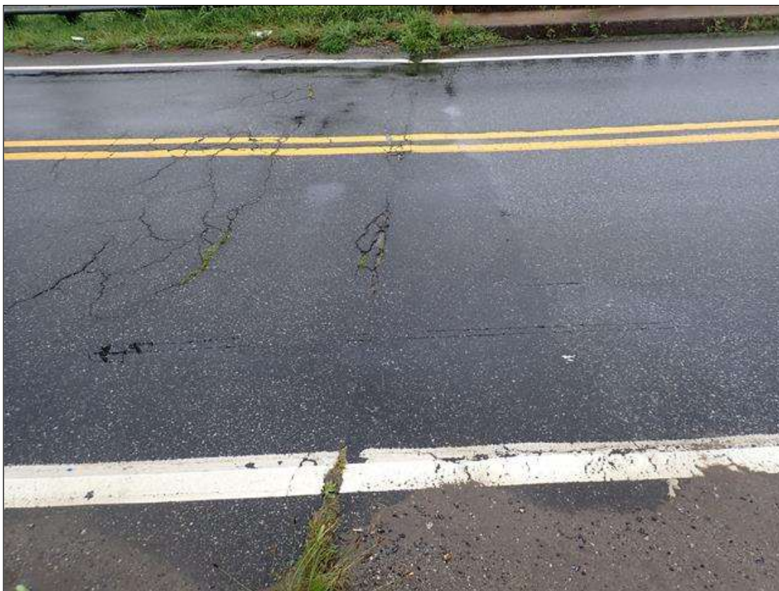
end bent 1 asphalt
